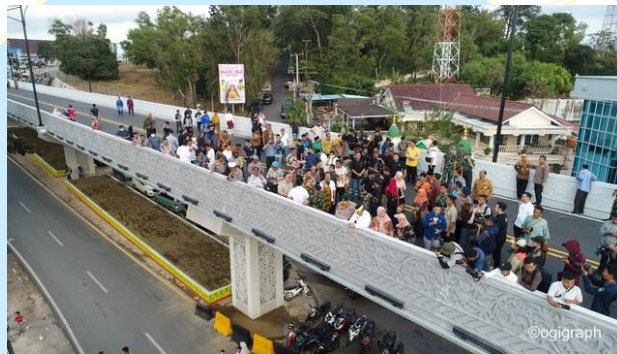
Gambar 1.1 Jembatan Layang(Flyover) Tanjungpinang
