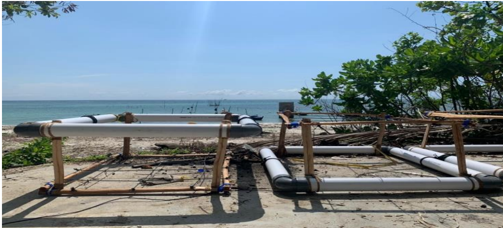
Gambar 6. Kerangka metode rakit apung
