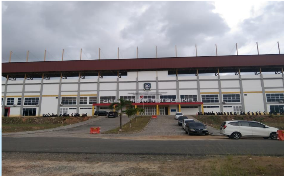
Gambar 1.3 Gedung Dinas Pemuda dan Olahraga Provinsi Kepulauan Riau
