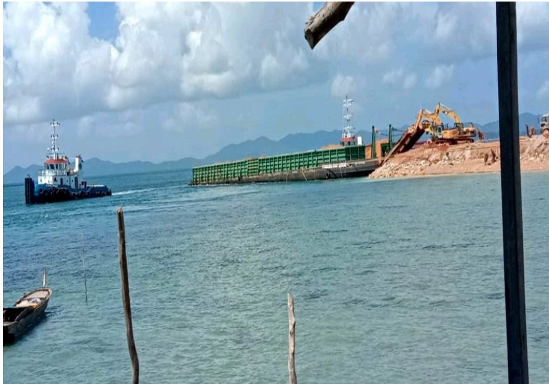
Gambar 1. 2 Pemangkasan Bukit dalam Pembangunan Pariwisata dengan Metode cut and fill
