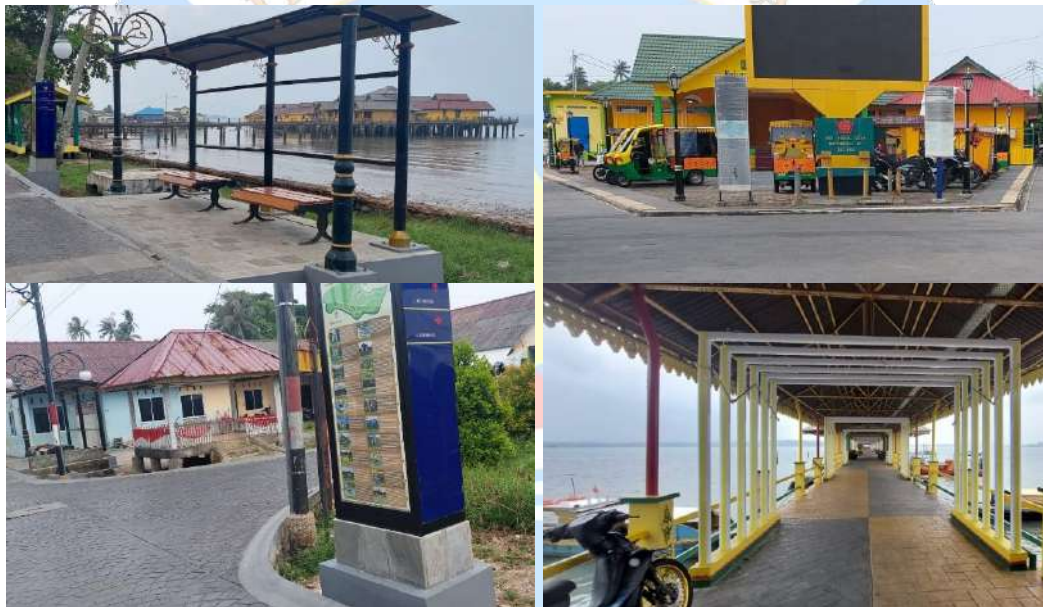
Gambar 1. 1 Beberapa Fasilitas Publik Wisata Pulau Penyengat yang sudah di perbaiki
