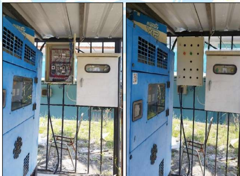
Gambar 37. Hasil Pemasangan Panel Pada Enclosure Genset
