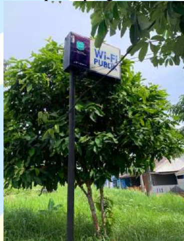
Gambar 4.5 Penempatan yang tidak sesuai
